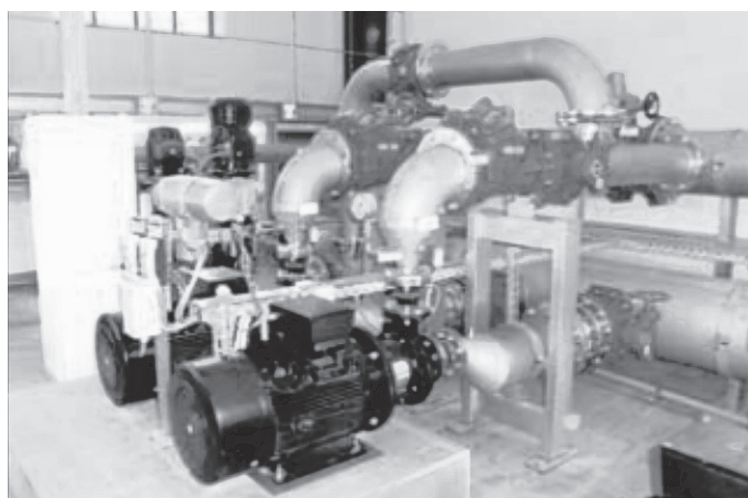
Trinkwasseraufbereitungsanlage im Wasserwerk
