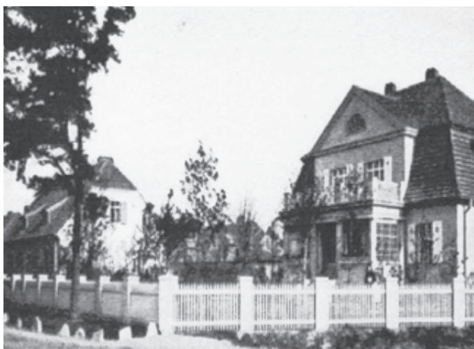
Wohnhaus des Anstaltsleiters
