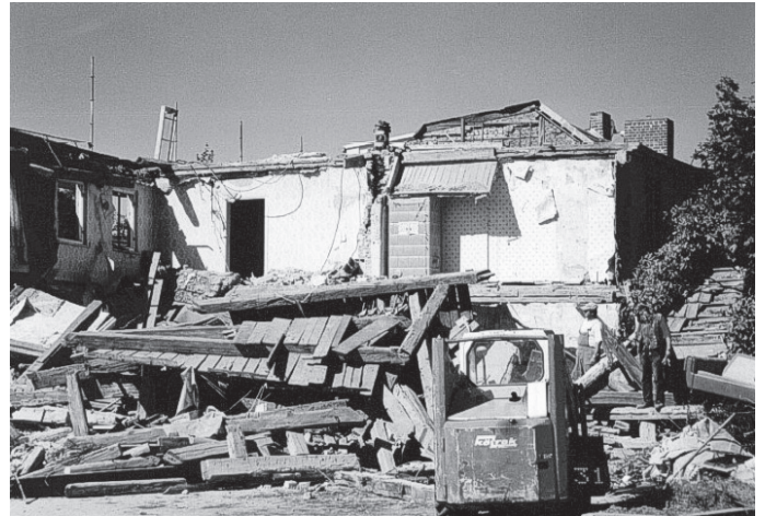
Der Abriss des einstigen Schulgebäudes. Jede Menge Holz war hier verbaut worden. Aufnahme vom 31. August 2005
