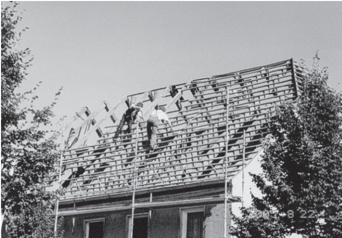
Da das Dach einige Jahre zuvor neu eingedeckt wurde, fand man für die Dachziegel noch Verwendung. Sie wurden Stück für Stück abgetragen. 22. August 2005
