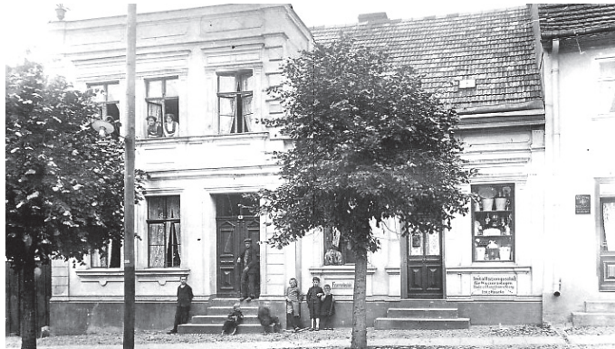
Eine Aufnahme von 1912, nachdem Herr Haucke die linke Seite vom Dach ausbauen ließ. Rechts ist noch die Ladentür erkennbar vom Uhrmachersgeschäft W. Wendorff im Hause Sucrow.
