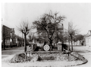
Abbruch und Neuaufstellung des Kriegerdenkmals 1870/71 in Biesenthal. Neuer Standort ist die Gabelung Fischerstraße – Breite Straße. Im Blick die Baugrube. Auf- gestellt im Dezember 1938
