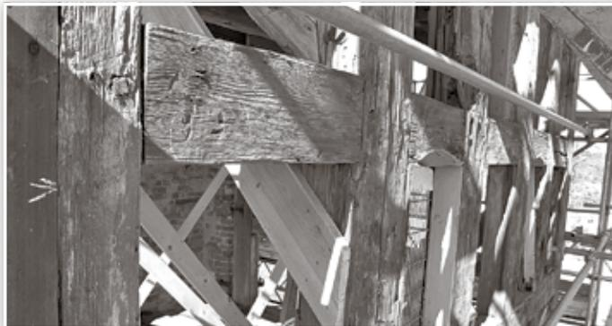
Abb. 2, Ostseite der hölzernen Turmkonstruktion Dorfkirche Rüdnitz während der Sanierung des Turmes 2016, nach der Abnahme der Verbretterung traten an den Außenseiten der Hölzer die dazugehörigen Abbundzeichen zu Tage, Blick von Nordosten
