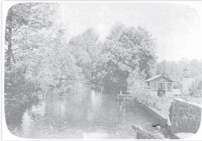
Aufnahme von 1911 nach dem Brand der Kietzmühle. Nur die Feldsteinmauer ganz rechts blieb stehen.
