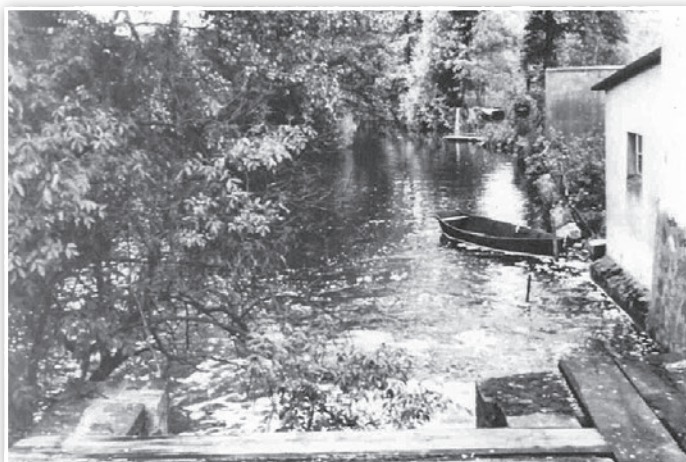
Die Kietzmühle am Wehr. Der Originalverlauf der Finow an der Mühle vorbei. Ca. 1930
