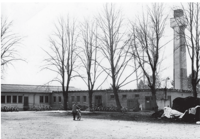
Minischule und Heizhaus Rechter Hand das Heizhaus mit dem Schornstein. Linksseitig das Gebäude der „Minischule“, Aufnahme von 1984.
