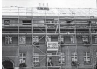
*In den Schulferien 1998 wird das Dach des Schulgebäudes neu eingedeckt. Noch erkennbar im Bild die 1972 nach dem schweren Sturm beim Dachausbau eingebauten Schleppläuben.*
