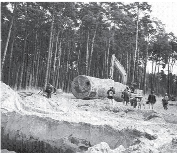
Der 1. Tank wurde hochgezogen, vor Ort von einem Greifer zusammengepresst, anschließend gestanzt, sodass nur noch eine große Blechplatte übrig blieb.
