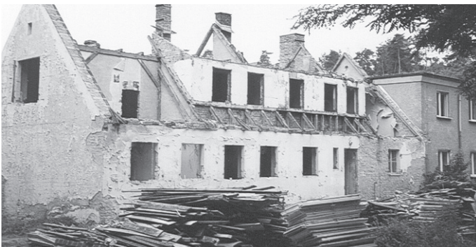
Diese Villa wurde im August 1995 abgerissen.
