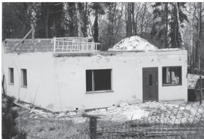
Aufnahme v. 17.03.1999 Das Haus wird abgerissen, um für einen Neubau Platz zu schaffen.
