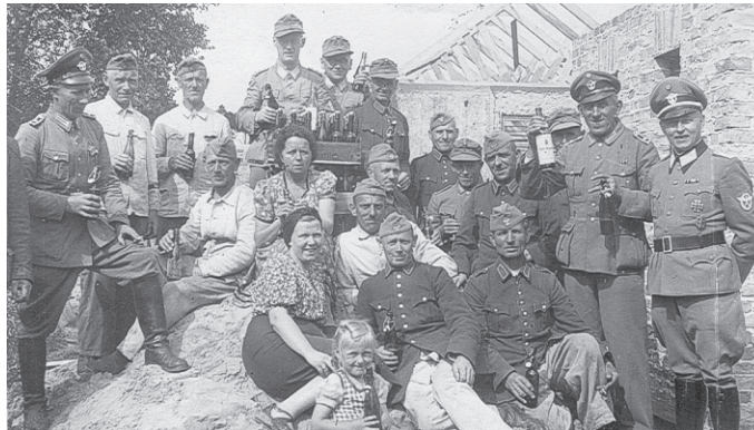
Aufnahme 1943 – Bau der Behelfsheime in der Prenderer Straße Nähe Kesselsee. Die Männer mit den dunklen Jacken sind tschechische Fremdarbeiter, sie waren im Lager „Heideberg“ untergebracht. Auch Frauen wurden beim Bau dieser Häuser herangezogen.
