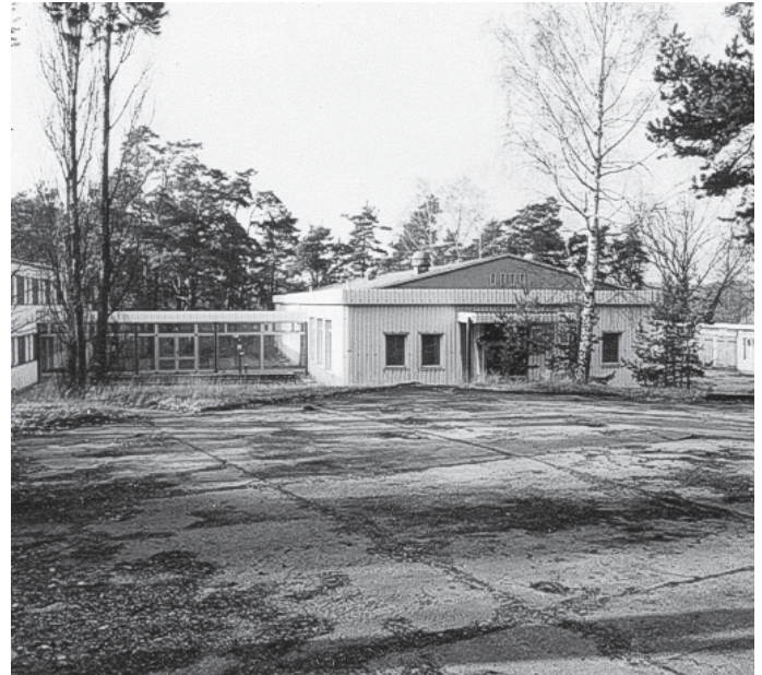
Aufnahme 1992 – Wirtschaftsgebäude vom MfS. Mitte der Küchentrakt, links: Dienststelle und Arztstation, rechts Garagenkomplex. Zu der Zeit sah die Gegend noch einigermaßen ordentlich aus. Inzwischen ist das Gelände zu einer wilden Müllkippe geworden.
