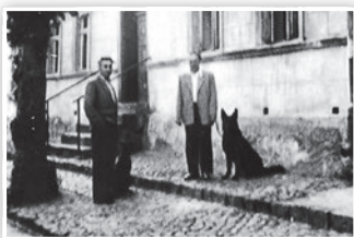
Ein Bild vom Haus aus dem Jahre 1953. Die Treppe wurde vom jetzigen Besitzer entfernt. Auch die Eingangstür ist nicht mehr vorhanden.
