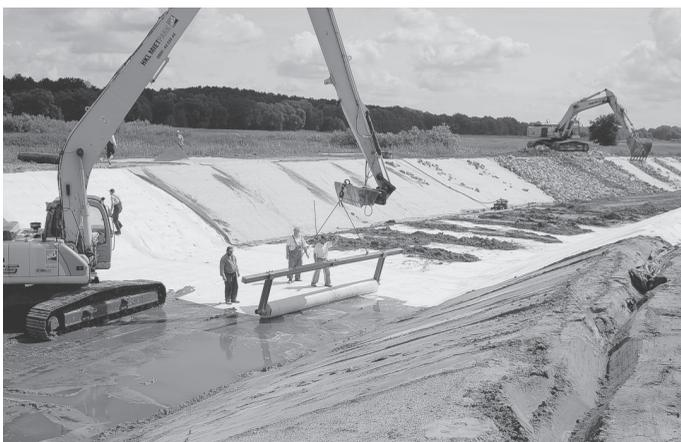
Einbau einer geosynthetischen Tondichtungsbahn, Juli 2009
