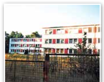
Dreigeschosser im Ferienlager. Später wurden diese Dreigeschosser gebaut. Jedes Haus hatte einen Namen: I. Bärenhöhle, II. Vogelnest, III. Fuchsbau, IV. Biberburg. Im Herbst 1999 begann der Abriss dieser Wohnblocks.
