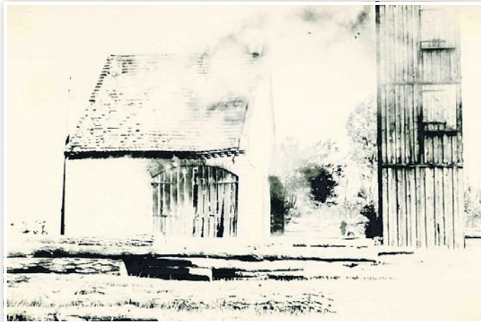
In der Scheune linker Hand entstand das Feuer und griff über zum nebenstehenden Feuerwehrturm. Geschehen im Mai 1957. Spielende Kinder in der Scheune lösten das Feuer aus.
