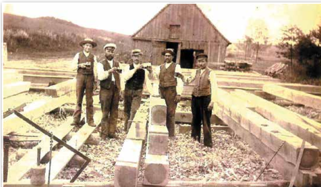
Scheunenbau am Langeröner Weg. Biesenthaler Zimmermänner bei der Arbeit. In der Mitte: Zimmermann Theiling. Er wohnte im Haus „Zur Flora“ in der Grünstr. Nr. 1.
