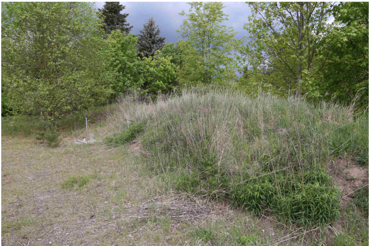
Abbildung 2: kleine Aufschüttungen und Dämme in Teilbereichen des Geländes
