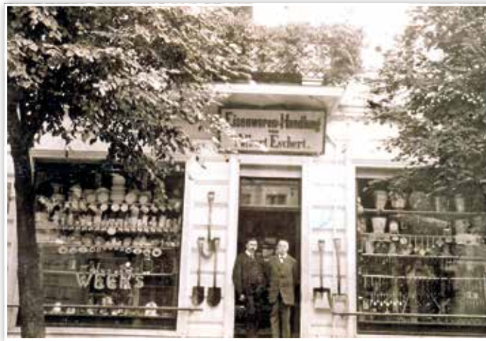
Nach dem Umbau und Aufstockung des Hauses von 1912. Reklame über der Eingangstür: „Eisen- und Wirtschaftsartikel“
