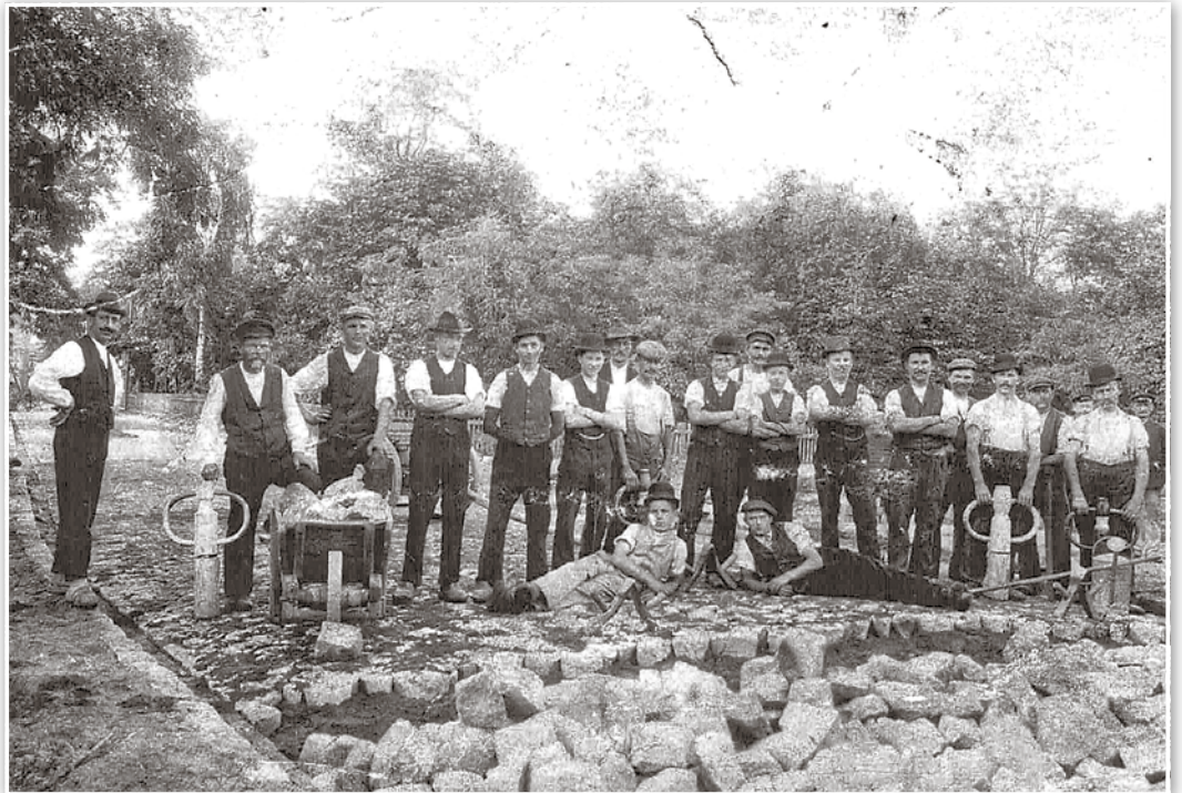
Aufnahme vom 19.08.1910: Die Bahnhofstraße in Biesenthal wird gepflastert. Die Arbeiter des Steinmetzmeisters von Herrn Hermann Plenske sind hier am Wirken.
