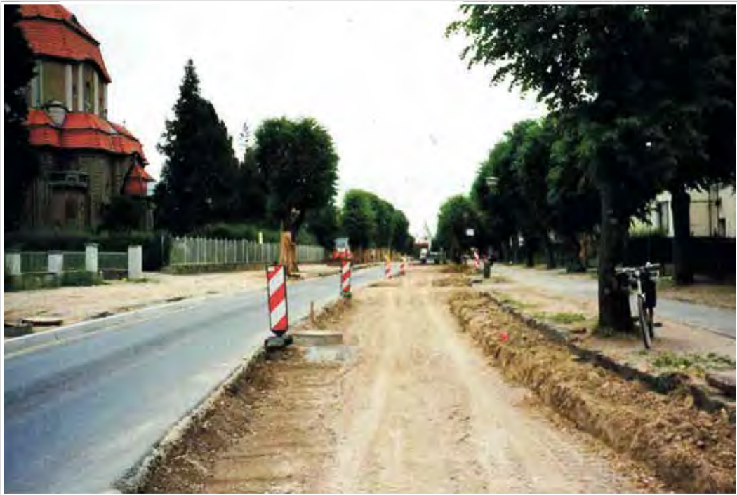
Sanierung der Bahnhofstraße entlang des Anwesens der Katholischen Kirche. Aufnahme vom 23.06. 1999
