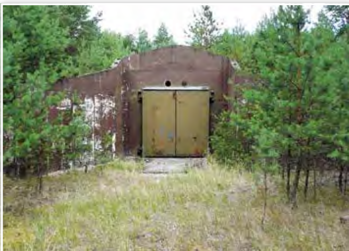
Der verschweißte Eingang zum Mdi-Bunker bei Klobbicke Bild: www.untergrund-brandenburg.de
