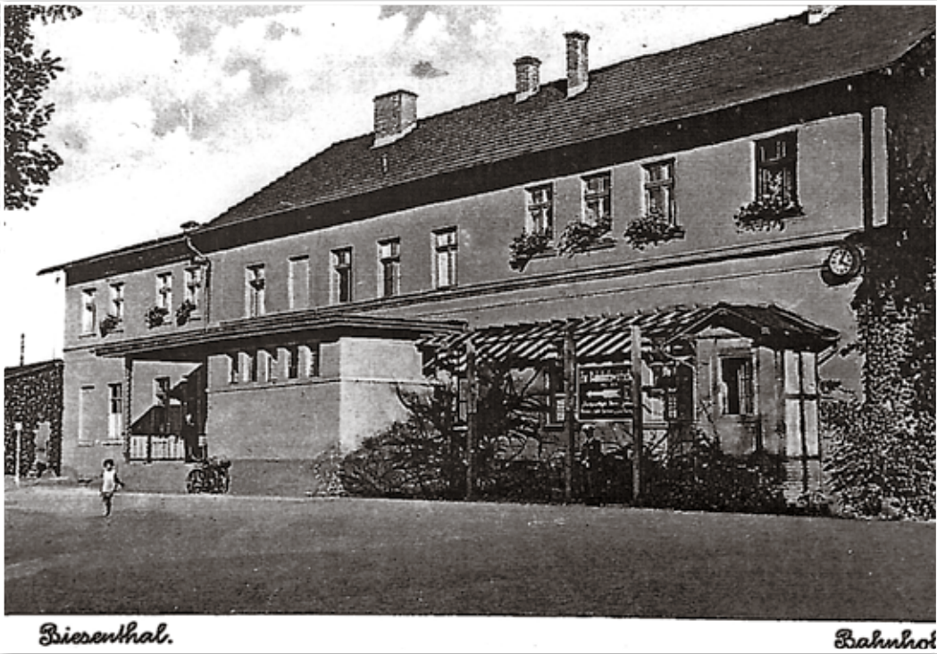
1940 Das Bahnhofsgelände von Biesenthal.
