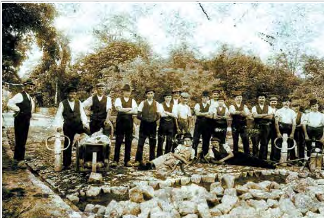
19.08.1910 Pflasterung der Bahnhofstraße.
